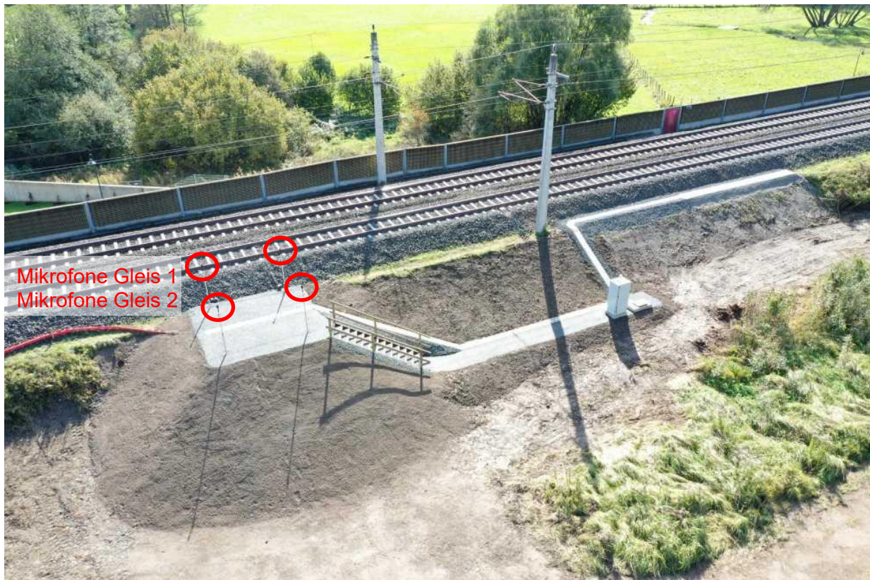
Abbildung 2: Ansicht der Schallemissions-Messstelle Lind ob Velden von Norden, (c) ÖBB-Infrastruktur AG
