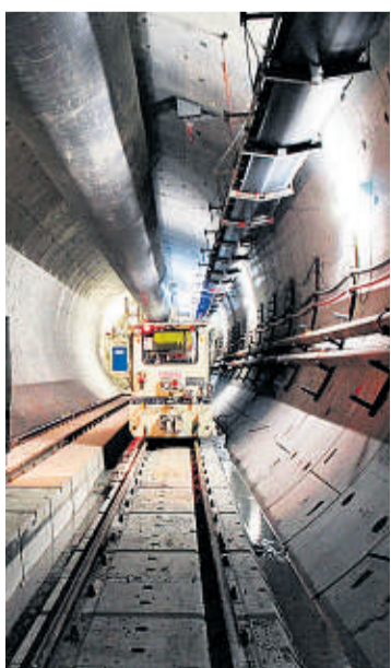
Der Koralmtunnel ist Herzstück des Ausbaus der Südstrecke.
