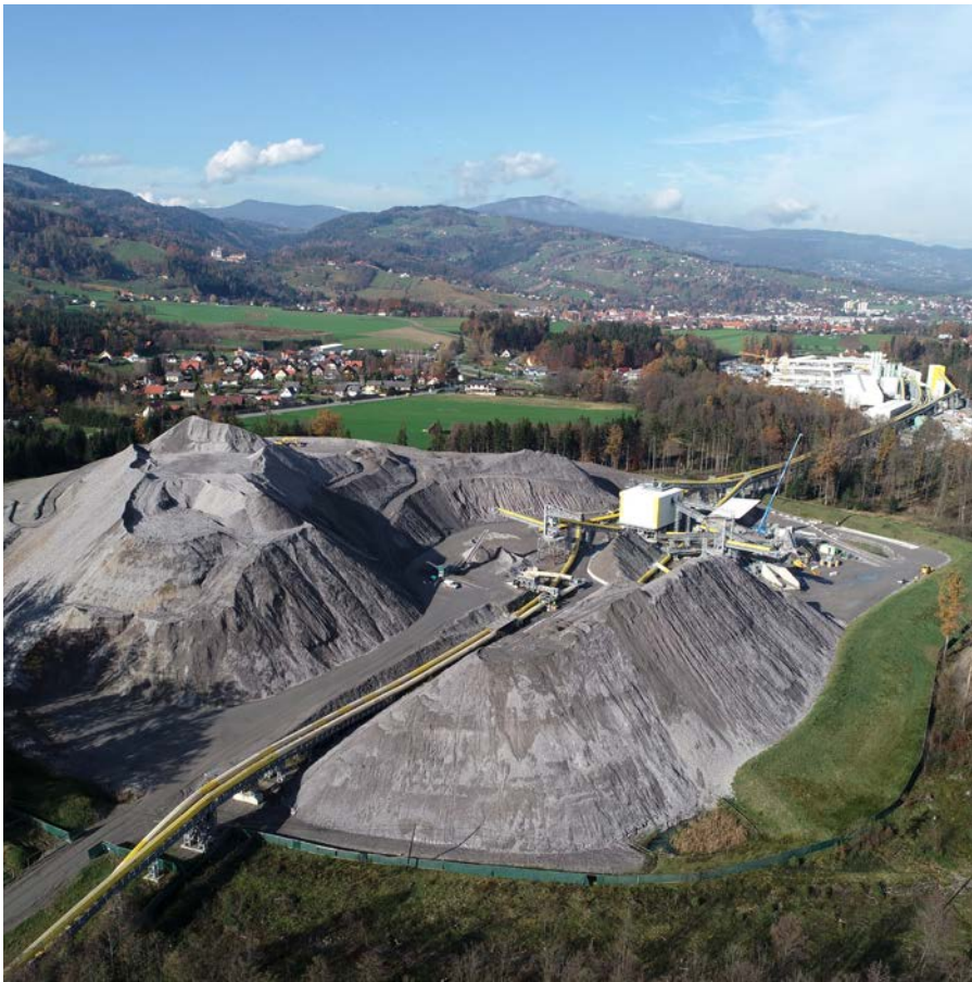
VOM ABFALL ZUM SEKUNDÄRRÖHSTOFF. Deponie auf der Großbaustelle der Koralmbahn
